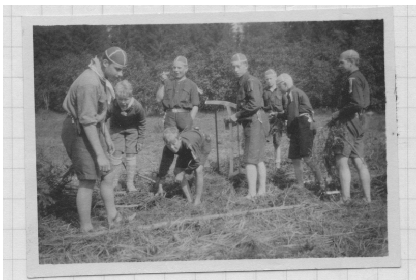
Leirillä sillan rakennusta.
